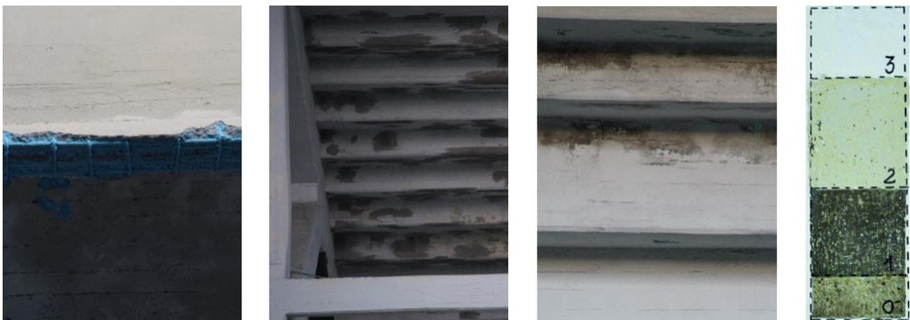
Rilievo fotografico sull'analisi del degrado delle superfici in calcestruzzo a faccia-vista
